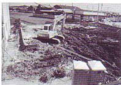
プール改修工事
